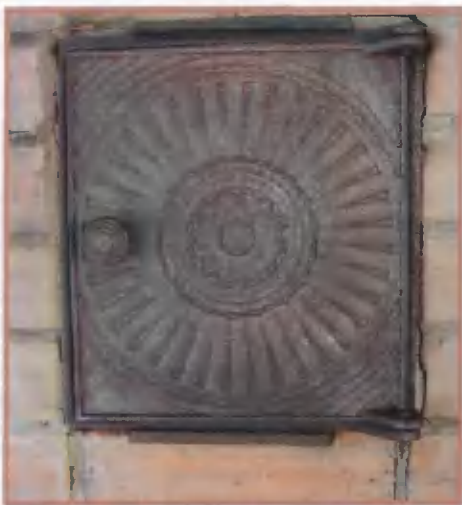
Эта дверца прослужила уже 20 лет. Пластины крепко держат коробку в кладке печи
